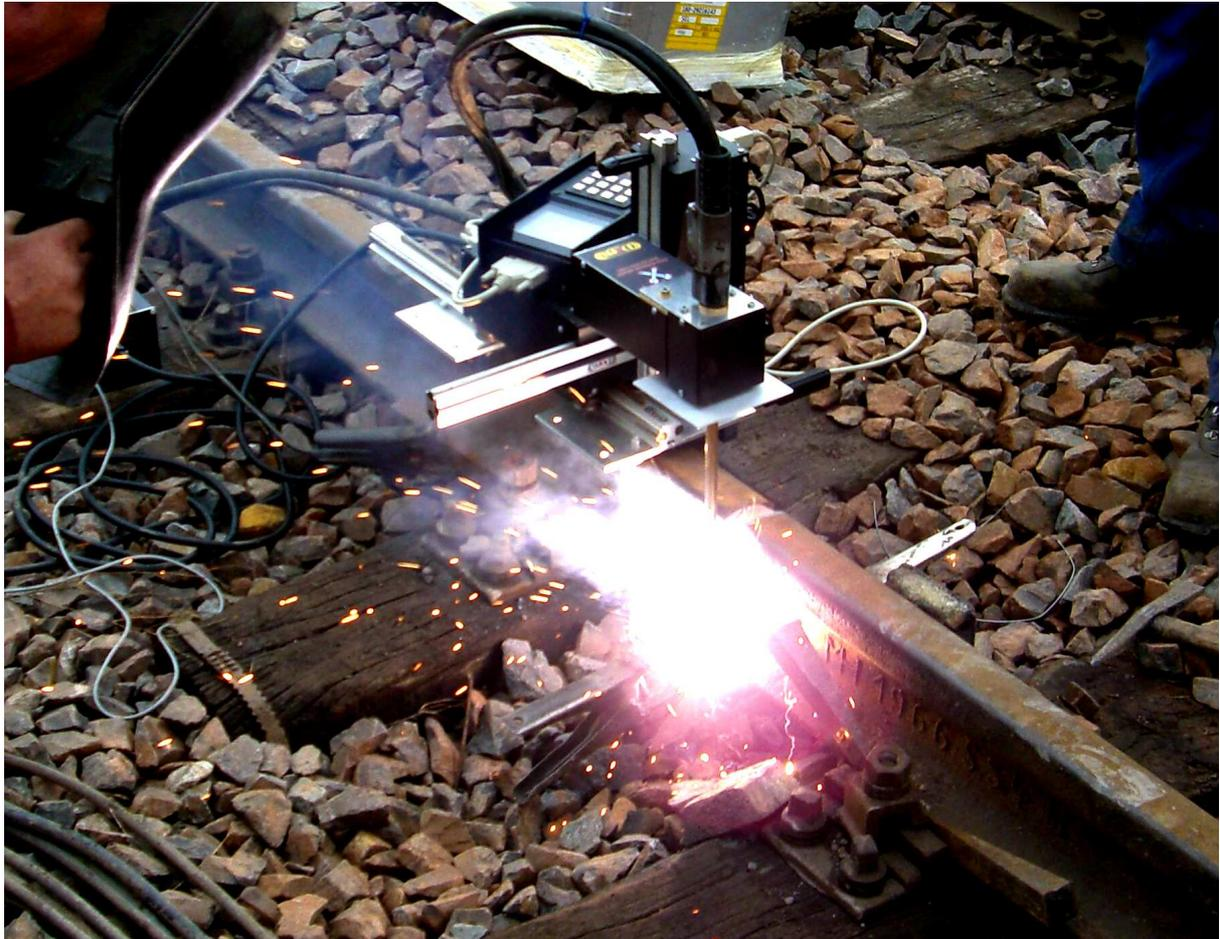
Höchste Qualität durch unterbrechungsfreie Arbeit. „In einem Zug“ vom Schienenfuß bis zum Kopfende.
